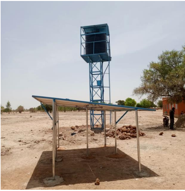
Transformation d'une pompe à motricité humaine en un poste d'eau autonome avec raccordement, à l'école Tambissini de Tibga
